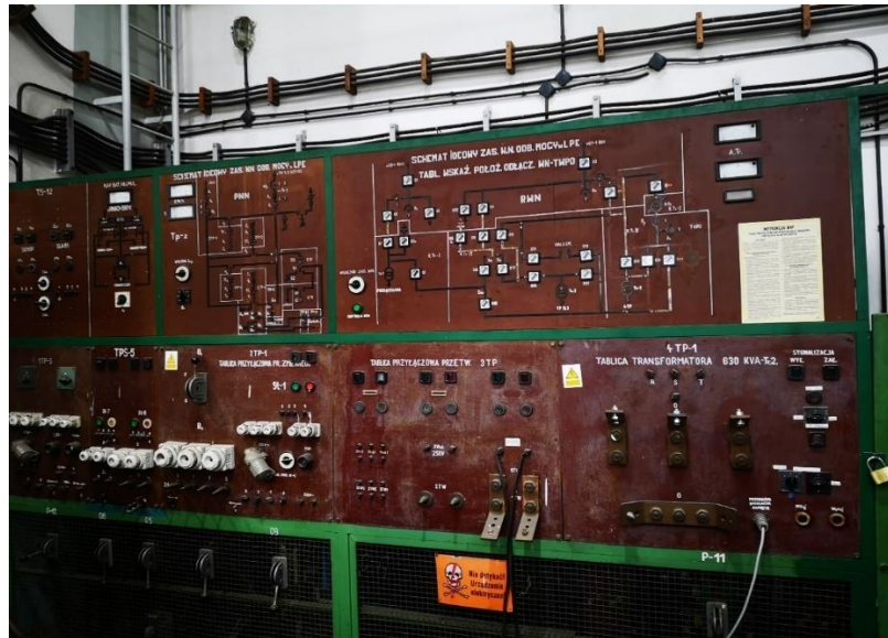
Fot. 3. Istniejąca tablica przyłączeniowa wraz z schematami ideowymi do odtworzenia.
