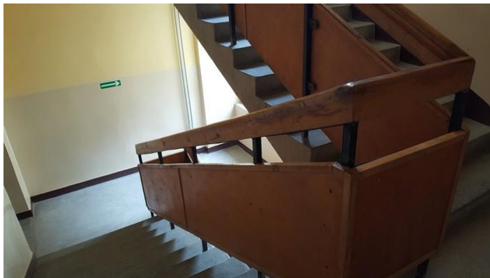
Rys. 9. Drewniane osłony balustrady na klatkach schodowych - docelowo do demontażu (źródło: wykonanie własne).
