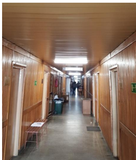
Rys. 7. Przykładowe miejsca występowania drewnianej okładziny ściennej (boazeria) - docelowo do demontażu (źródło: wykonanie własne).
