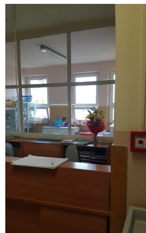
Rys. 3. Przykładowe miejsca występowania otworów w obudowie poziomych dróg ewakuacyjnych bez klasy EI (źródło: wykonanie własne).
