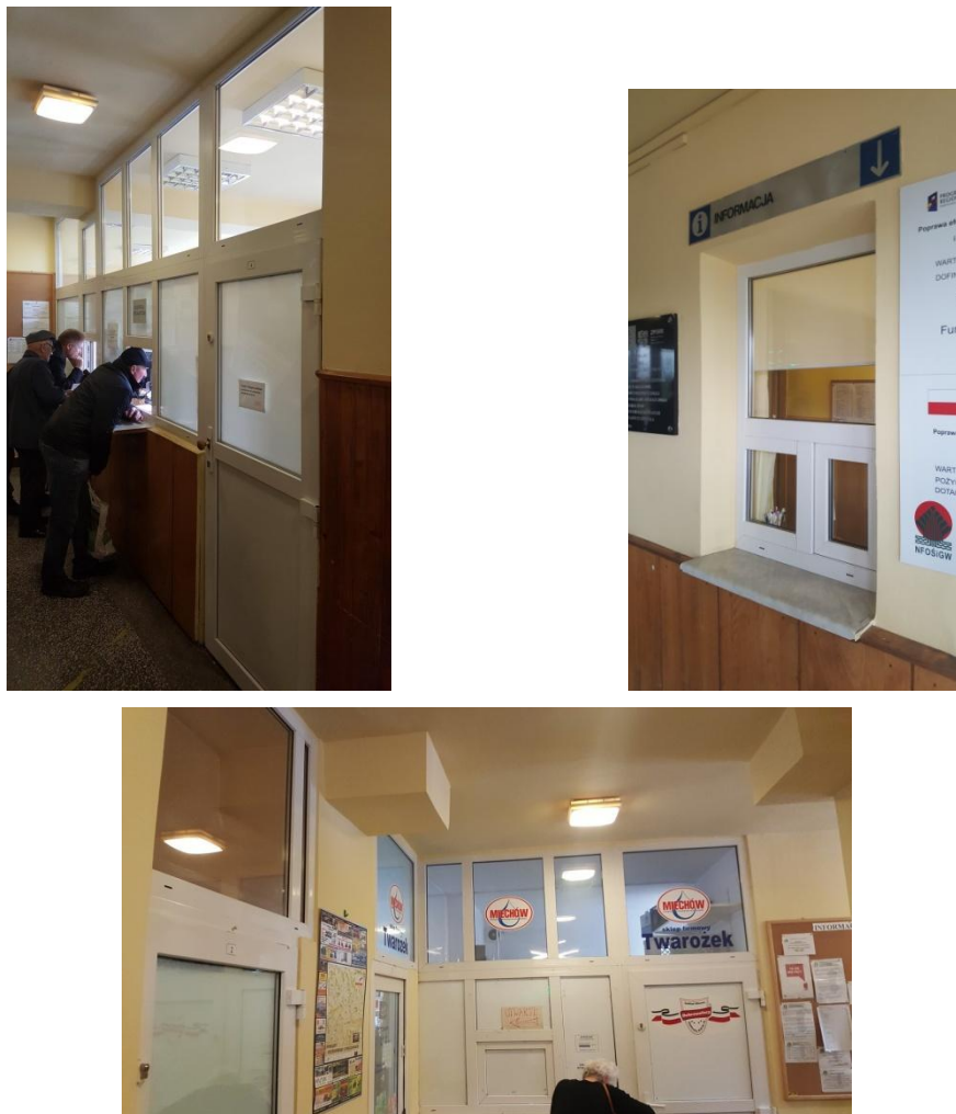
Rys. 6. Przykładowe miejsca występowania otworów w obudowie poziomych dróg ewakuacyjnych bez klasy EI (źródło: wykonanie własne).
