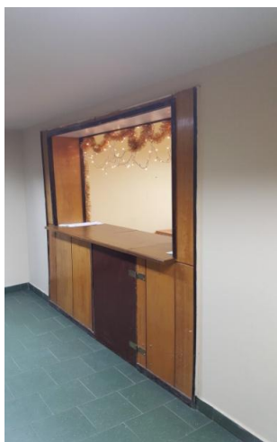
Rys. 5. Przykładowe miejsca występowania otworów w obudowie poziomych dróg ewakuacyjnych bez klasy EI (źródło: wykonanie własne).
