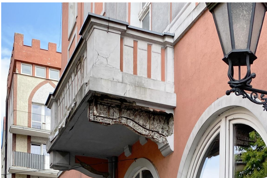
Fot.2. Stan balkonu z kwietnia 2024 r. Widoczna warstwa tynku wspornika prawego.
