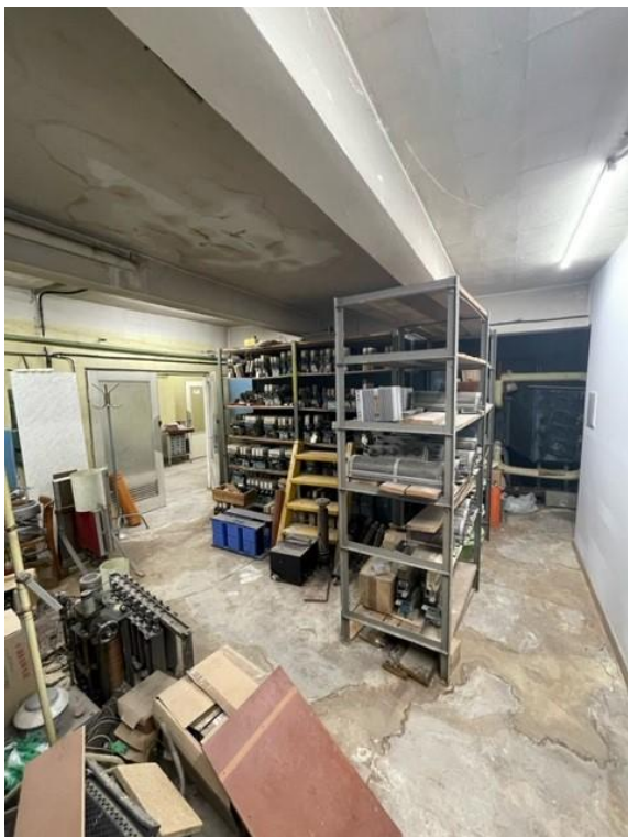
Widok na pomieszczenie przeznaczone na magazyn ciepła – możliwość rozbudowy istniejącej kotłowni
