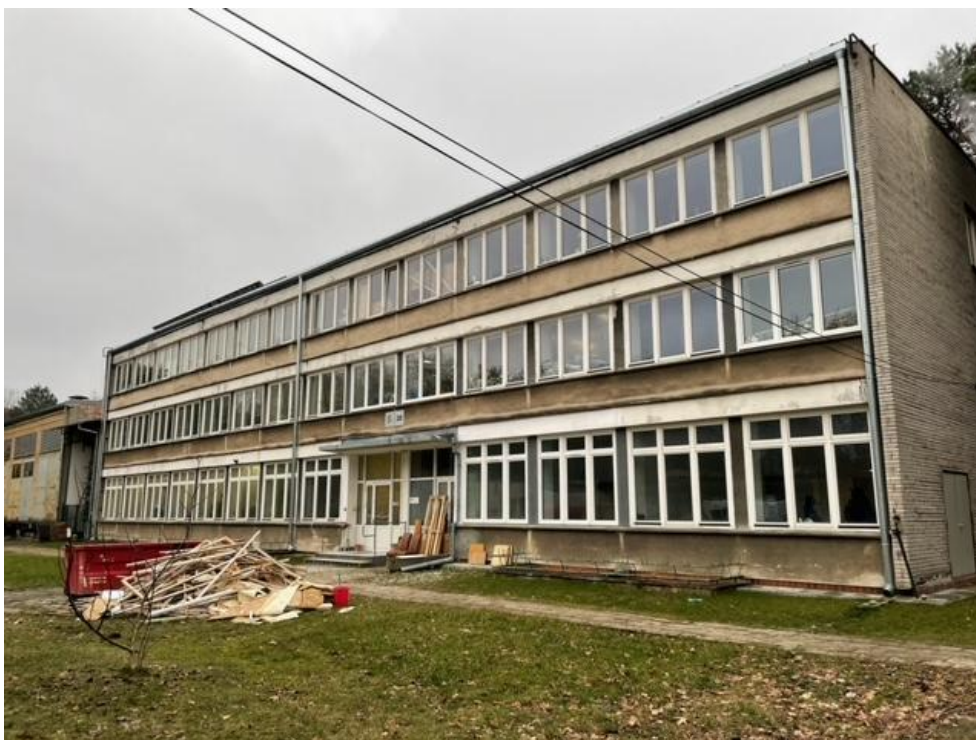
Widok budynku 20 od północy
