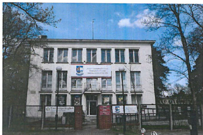
widok od strony południowej
