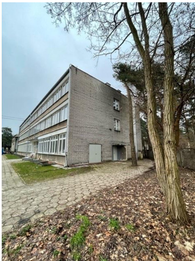
Widok budynku 20 od północy
