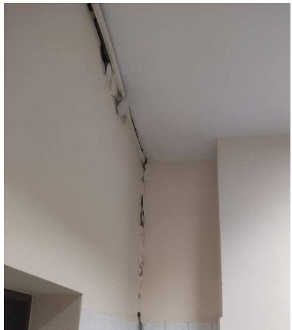
Fot. 11 Pęknięcie w miejscu połączenia ze sobą dwóch ścian wewnętrznych części składowych szkoły powstałych w różnych okresach czas
