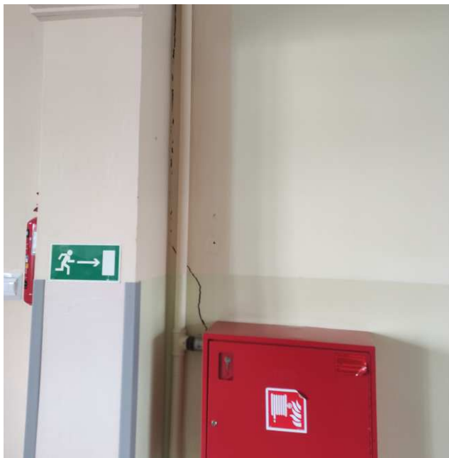
Fot. 11 Pęknięcie w miejscu połączenia ze sobą dwóch ścian wewnętrznych części składowych szkoły powstałych w różnych okresach czas
