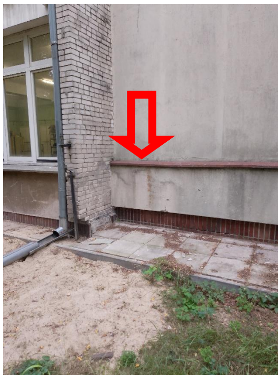
Fot. 23 – lokalizacja jednostek zewnętrznych klimatyzacji
