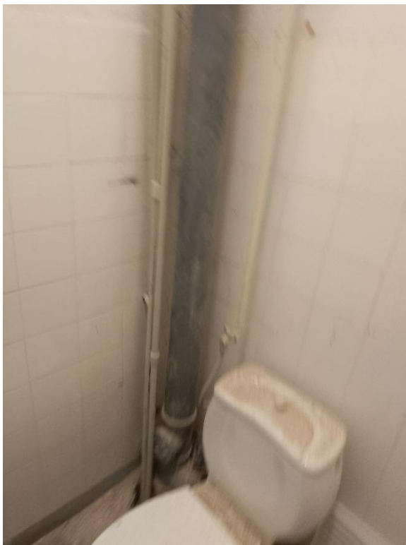
Fot. 36 – stara toaleta do demontażu lub ukrycia, nowa wpięci boczne
