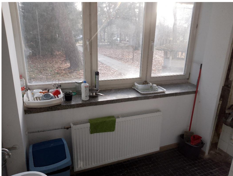
Fot. 27 – ściana zewnętrzna odnowiona w projekcie termomodernizacji, nowa instalacja CO. Do usunięcia stary pion z nieużytkowanymi rurami w pom. 15
