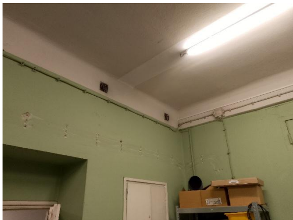
Fot. 12 Przykładowe pomieszczenie z okablowaniem do demontażu
