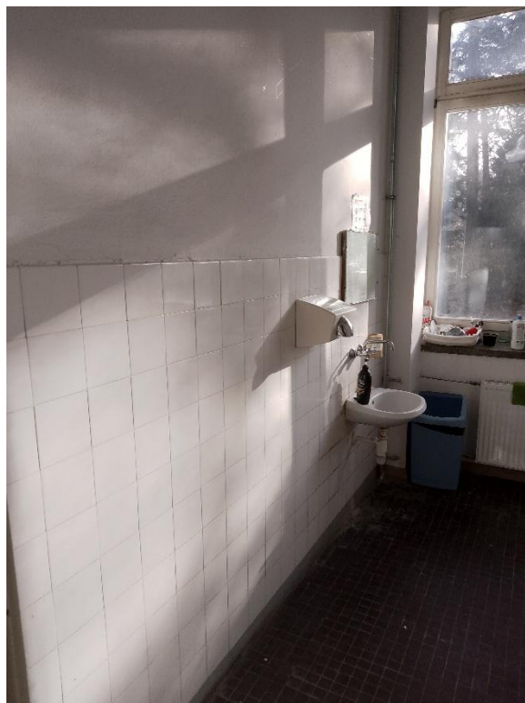
Fot. 30 – stare płytki ściennie do demontażu i przygotowanie powierzchni pod nowe
