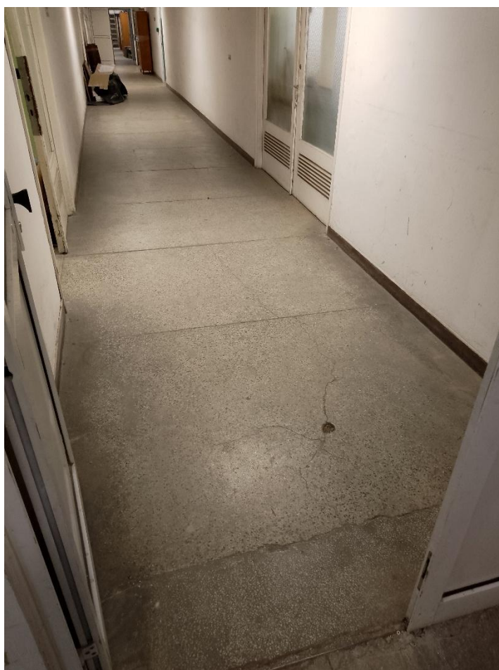
Fot. 20 – istniejąca posadzka lastryko w korytarzu remontowanego skrzydła
