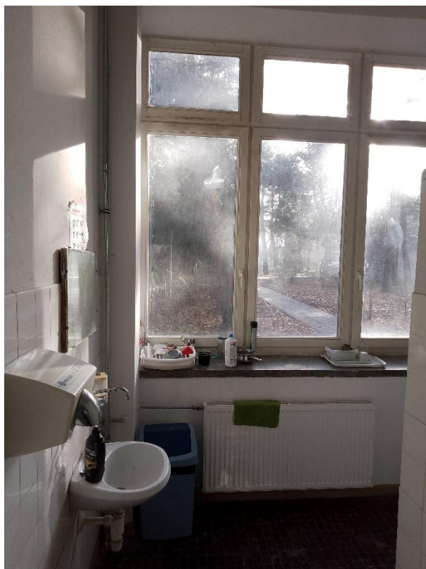
Fot. 29 – do usunięcia stara armatura i ceramika i jeżeli to konieczne do wycięcia rury stalowe
