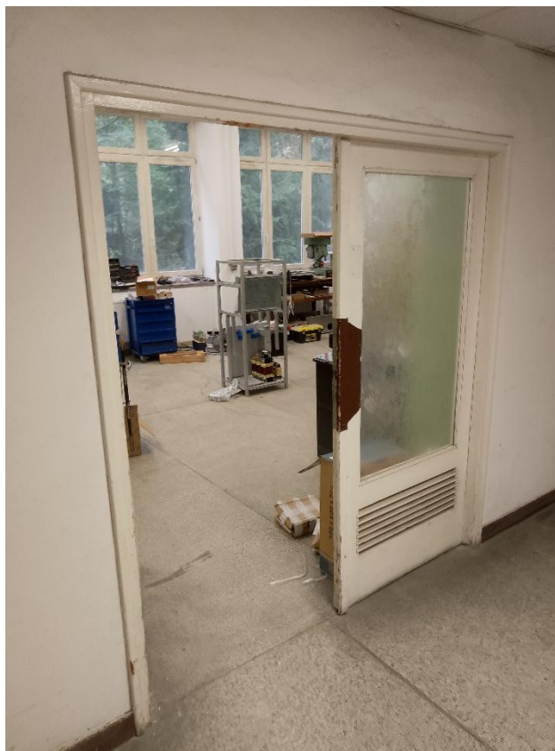
Fot. 7. Istniejące drzwi do pomieszczenia 11(od korytarza)
