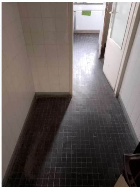
Fot. 25 – stara podłoga do rozkucia oraz wykonania wylewki dla nowych płytek w pom. 15
