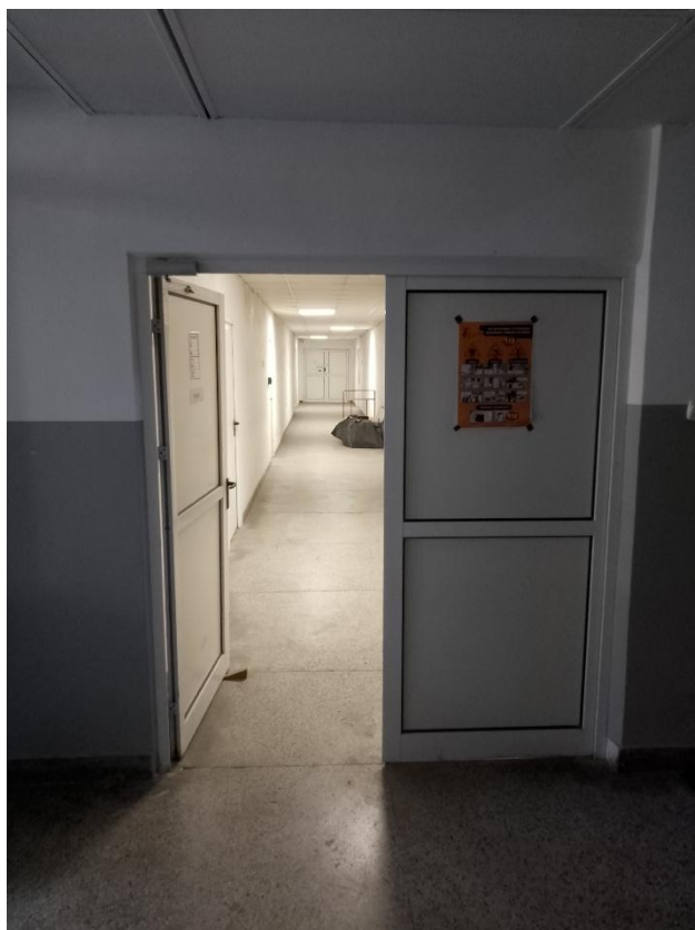
Fot. 5. Drzwi z klatki schodowej budynku 20
