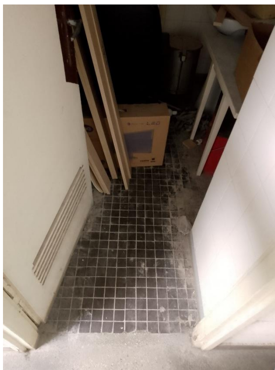
Fot. 26 – stara podłoga do rozkucia oraz wykonania wylewki dla nowych płytek w pom. 16
