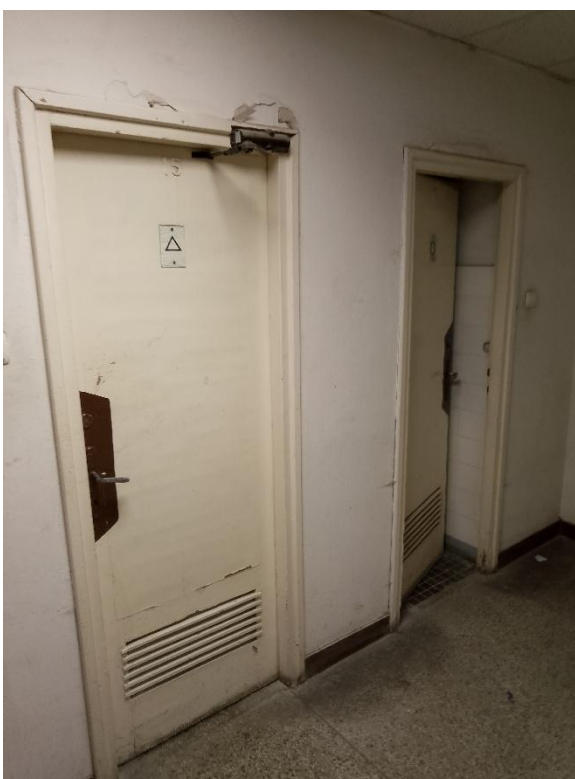
Fot. 37 – drzwi do toalet do demontażu. Nowe podcięte, otwierane na zewnątrz zgodnie z punktem B z samozamykaczami.
