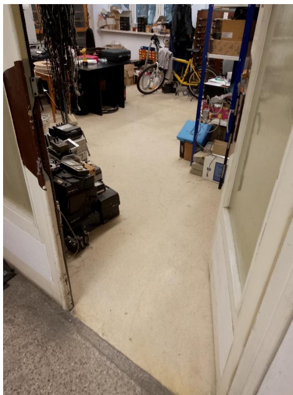
Fot. 21 – istniejąca posadzka lastryko w korytarzu remontowanego skrzydła
