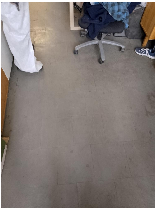
Fot. 22 – istniejąca posadzka wykładzina płytkowa PCV w pomieszczeniu nr 7
