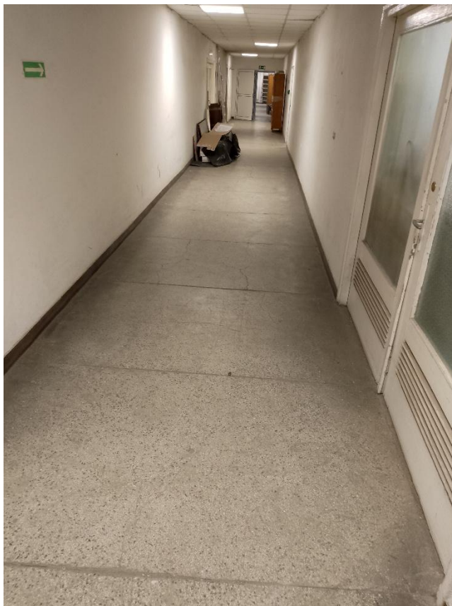
Fot. 21 – istniejąca posadzka lastryko w korytarzu remontowanego skrzydła
