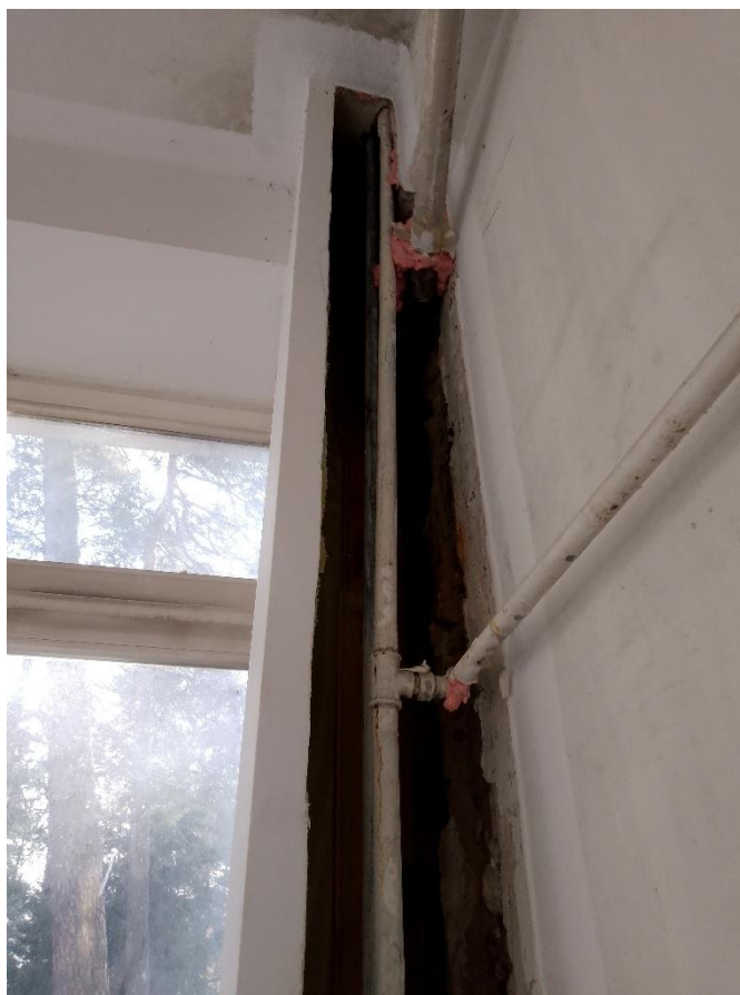
Fot. 28 – Do usunięcia i wycięcia stary pion z nieużytkowanymi rurami w pom. 15. Na I i II piętrze remont łazienek już wykonany i pion usunięty.
