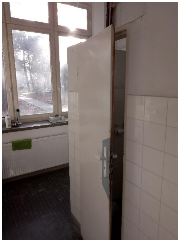
Fot. 31 – stara kabina ustępu do demontażu ze ścianami i drzwami oraz wykonanie nowej zielonej HPL (jak na piętrze I i II – zdjęcie poniżej)
