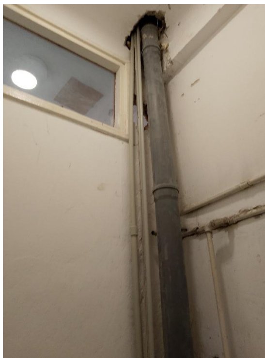
Fot. 35 – nowy pion kanalizacji i wody wymieniony podczas remontu łazienek na I i II piętrze. Miejsce włączenia się nowych instalacji. Okno do demontażu i zaślepienia
