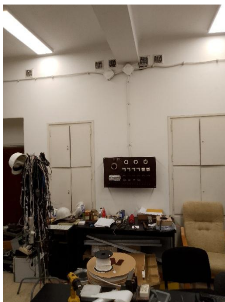
Fot. 16 – przykładowe pomieszczenie z szafami wnękowymi
