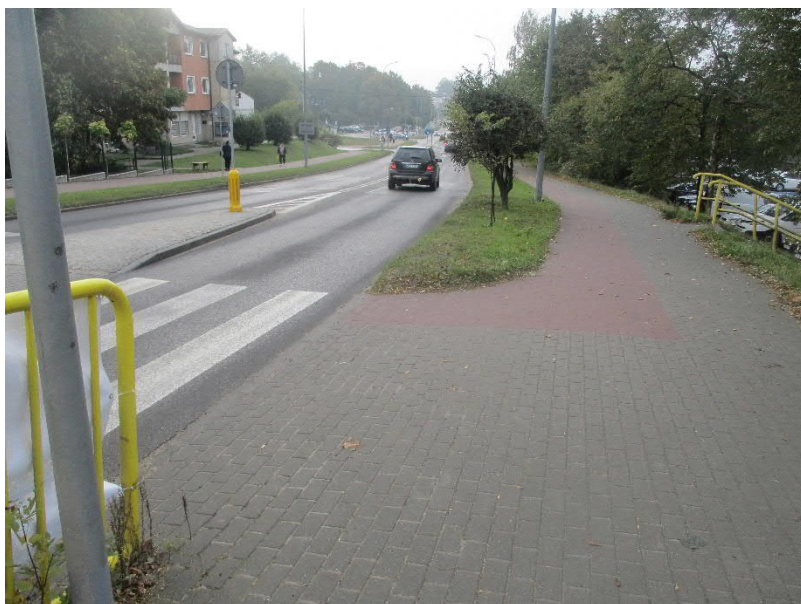
Foto 3. Wlot drogi wojewódzkiej nr 214 (południowy) – widok w kierunku skrzyżowania – urządzenia brd (U-11a) ograniczające pola widoczności w kierunku wschodniego wlotu ul. Wybickiego
