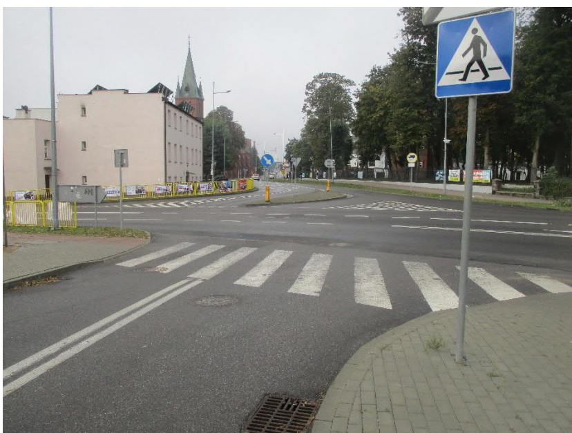
Foto 9. Włot ul. Wybickiego (wschodni) – widok w kierunku tarczy skrzyżowania – trasowanie korytarza ruchu do jazdy „na wprost” w obszar powierzchni wyłączonej z ruchu na przeciwnym wlocie ul. Wybickiego
