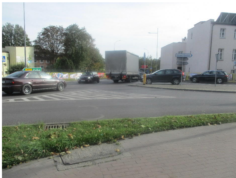
Foto 9. Włot ul. Wybickiego (wschodni) – widok w kierunku tarczy skrzyżowania – trasowanie korytarza ruchu do jazdy „na wprost” w obszar powierzchni wyłączonej z ruchu na przeciwnym wlocie ul. Wybickiego
