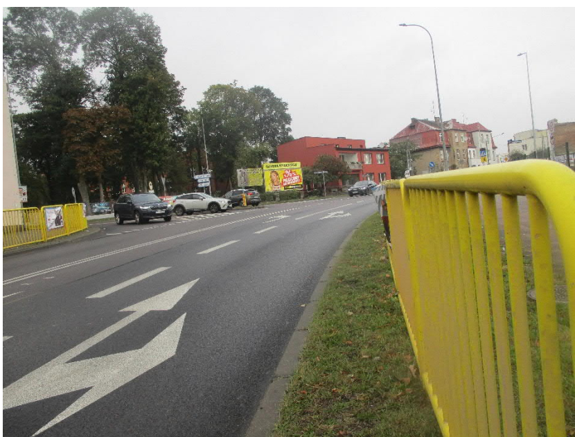
Foto 3. Wlot drogi wojewódzkiej nr 214 (południowy) – widok w kierunku skrzyżowania – urządzenia brd (U-11a) ograniczające pola widoczności w kierunku wschodniego wlotu ul. Wybickiego
