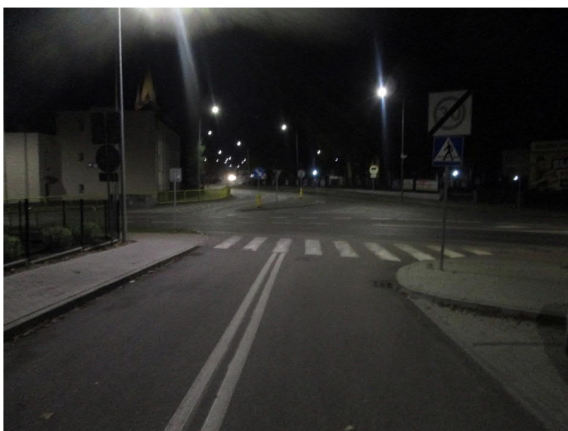
Foto 12. Wlot ul. Wybickiego (wschodni) – widok w kierunku skrzyżowania – nieprawidłowe warunki oświetlenia przejścia dla pieszych
