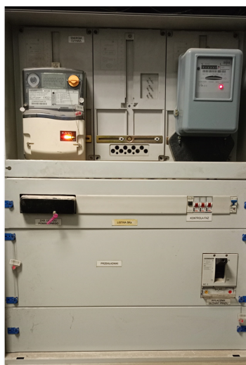
Fot. 1. Widok istniejącego układu pomiarowo-rozliczeniowego w rozdzielnicy RG.
