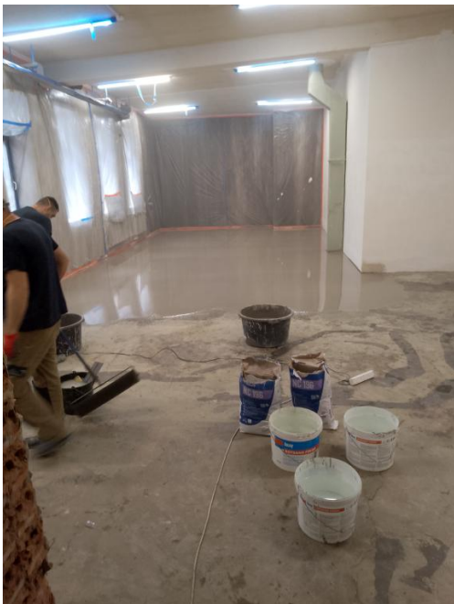
Fot. 17. Wykonanie wylewki pod nową żywicę masą samopoziomującą wzmocnioną typu NC196 lub równoważny zamiennik. Wykonania napraw przez szpachlowanie spękań
