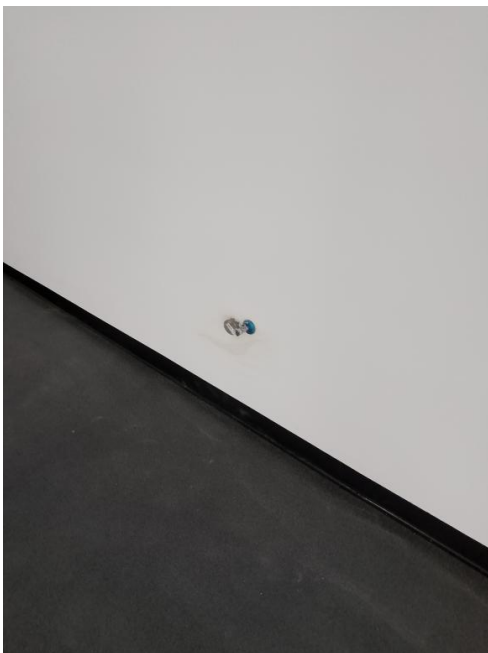
Fot. 16. Do wykonania żywica antyelektrostatyczna z kruszywem kwarcowym antypoślizgowa wykonana w jednym pomieszczeniu po remoncie. Malowane cokoły. – takie samo wykonanie w adaptowanych pomieszczeniach
