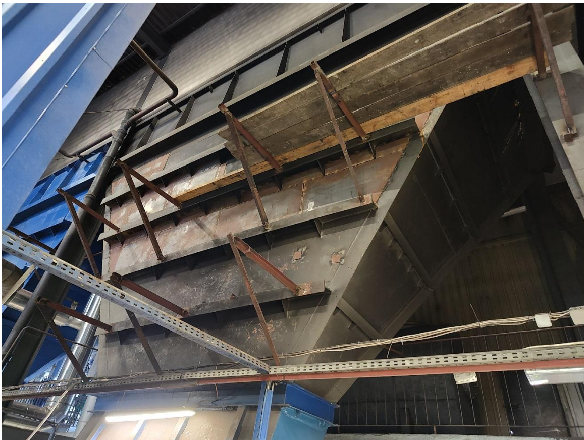
Zdjęcie 3. Widok zasobnika kotła nr 6
