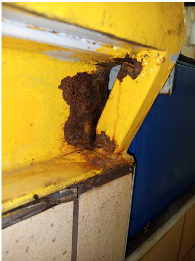
Fot.14 – Korozja elementu zamykającego tor od strony bramy wjazdowej
