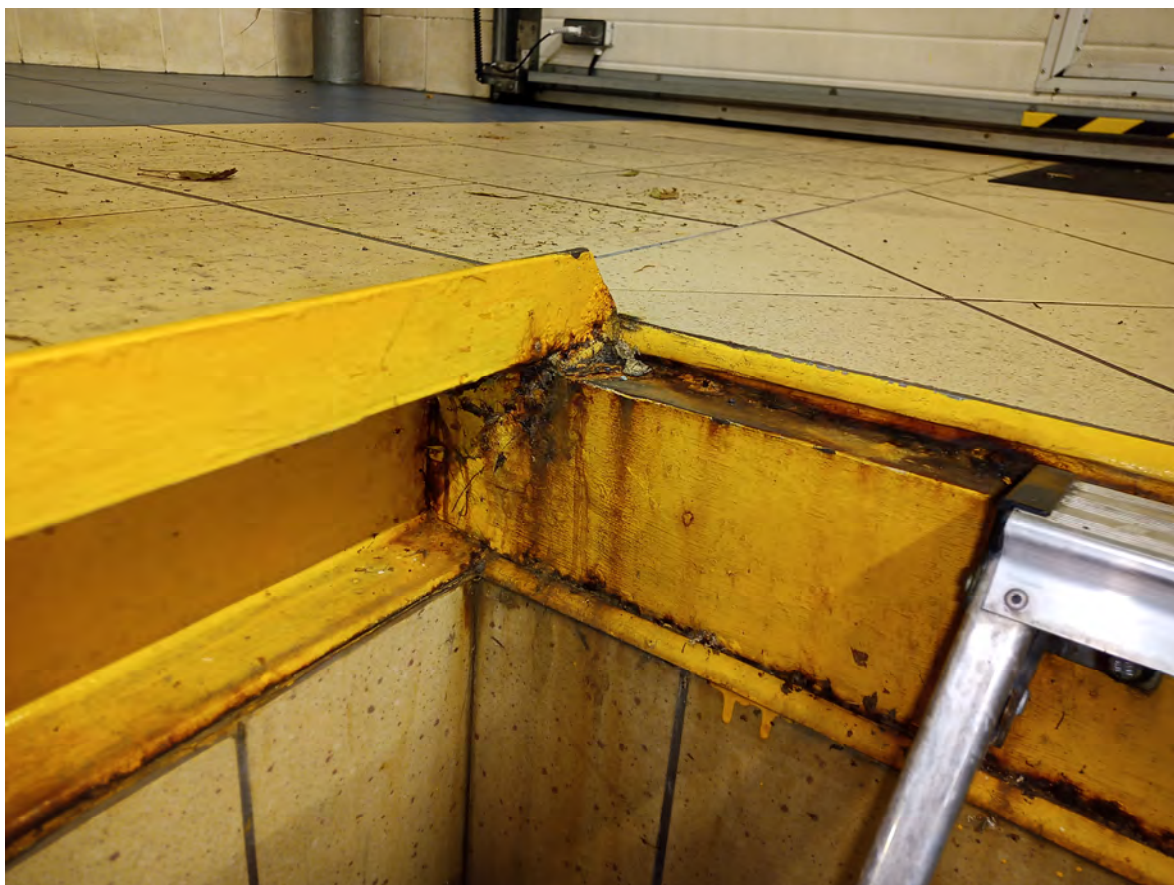
Fot.14 – Korozja elementu zamykającego tor od strony bramy wjazdowej
