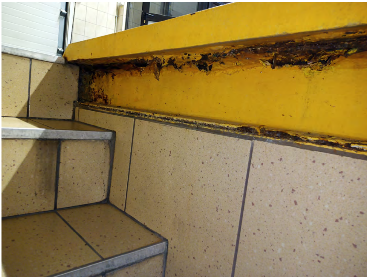
Fot.11 – Korozja toru c.d
