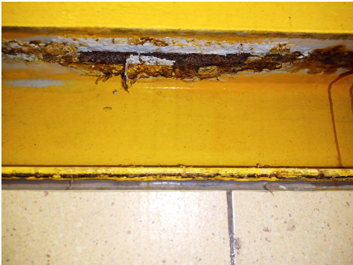
Fot.11 – Korozja toru c.d
