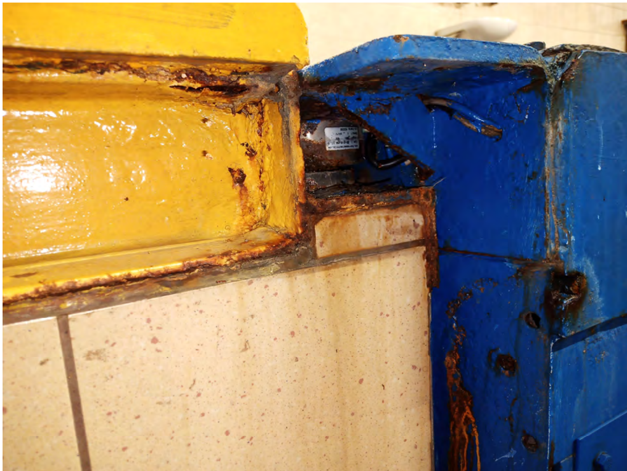
Fot.9 – Szczegół oparcia rolek – korozja toru na styku i obudowy urządzenia
