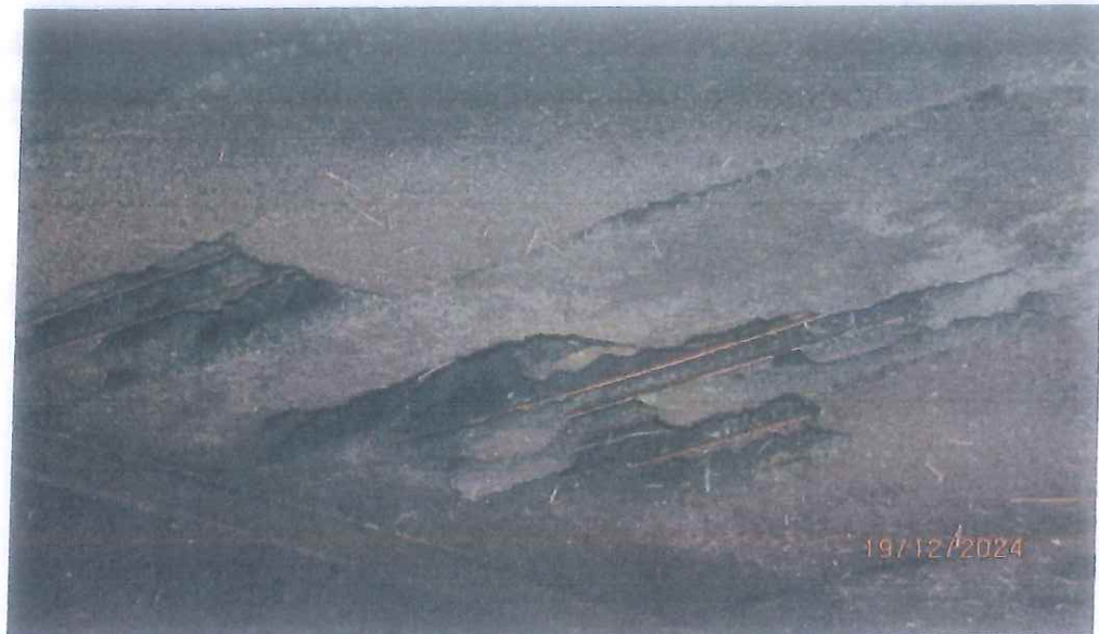
Ubytki otuliny płyt stropowych
